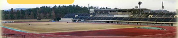
松江市営陸上競技場 改修
